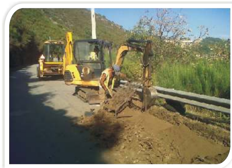
FOTO 3 - Prolongamento da Rede de Distribuição em Alta da Campeã às aldeias de Cotorinho e Montes.
