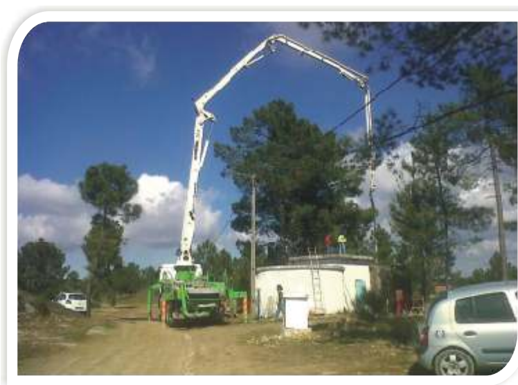
FOTO 1 - Reabilitação e ampliação do Reservatório de Carvas
