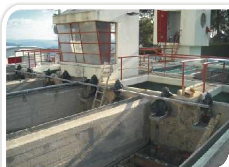
FOTO 2 - Obras de Reabilitação dos filtros da ETA do Alvão.
