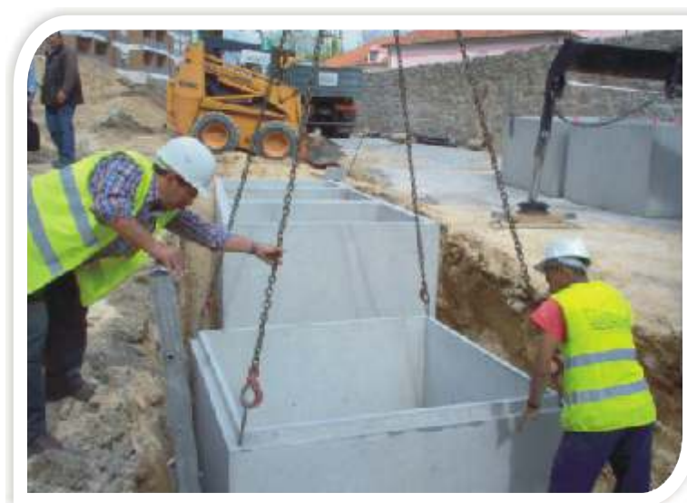
foto 5 - Fase de colocação de cubas em betão para Ecopontos enterrados.
